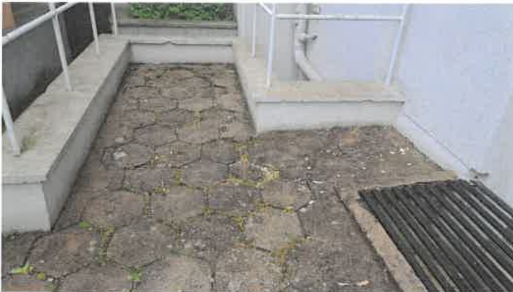
zdjęcie nr 12 ( przy schodach do nowego internatu )
